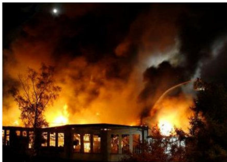
Der historische Schuppen brennt lichterloh. Foto: Stadt Nürnberg – Feuerwehr (Pressestelle)
